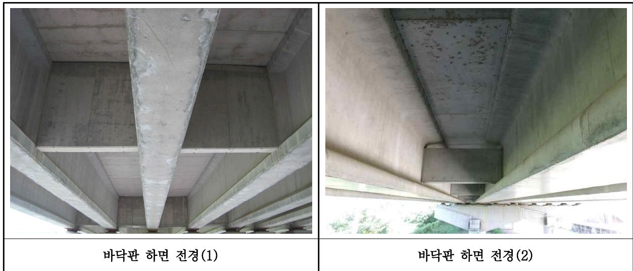
【사진 36.3.2】 바닥판하면 전경
