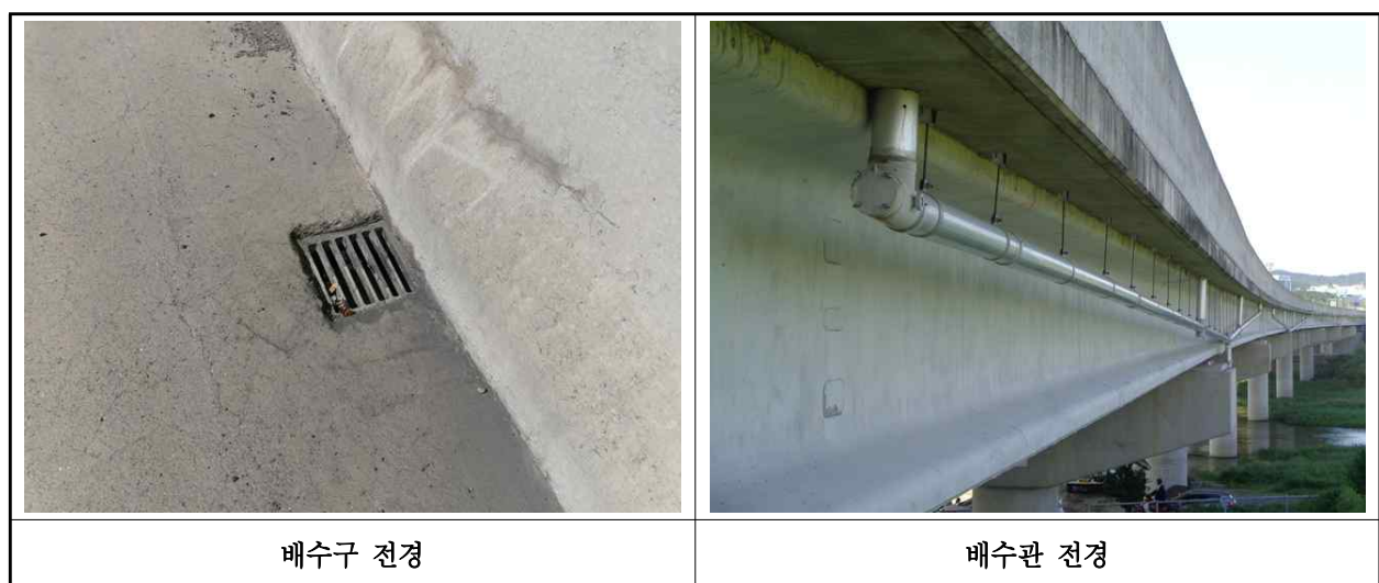
【사진 36.3.21】 배수시설 전경
