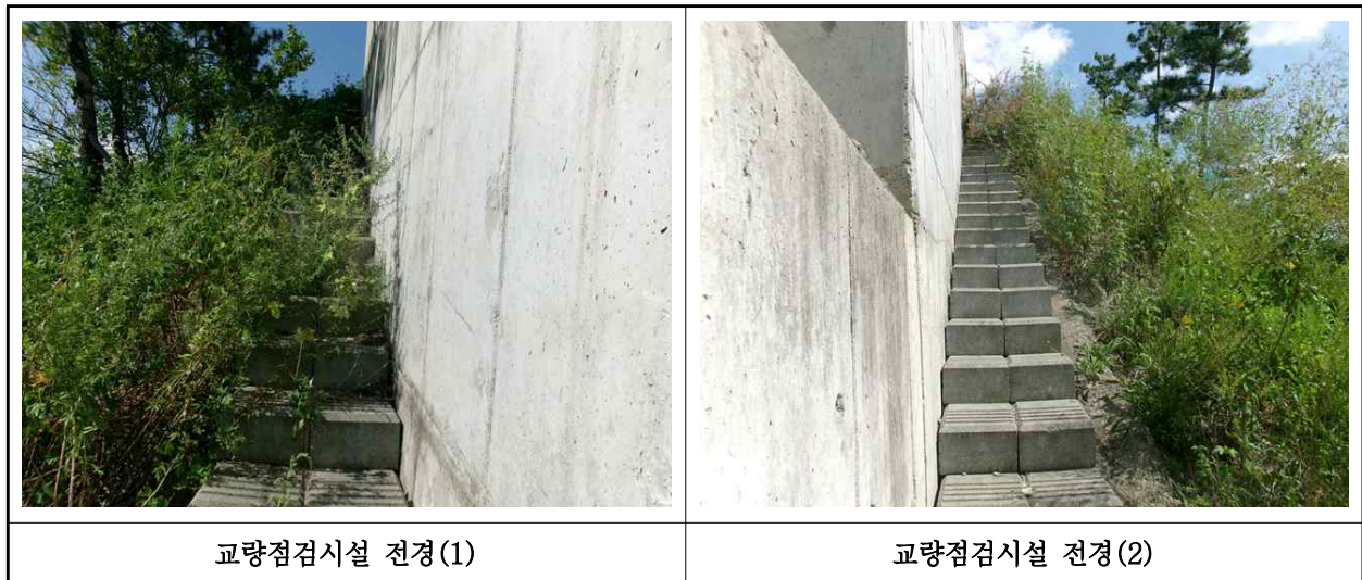
【사진 36.3.50】 교량 점검시설 전경
