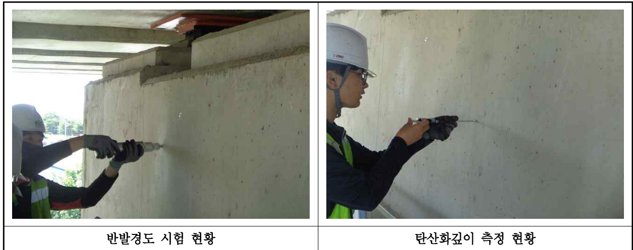
【사진 36.4.1】 콘크리트 내구성조사 현황
