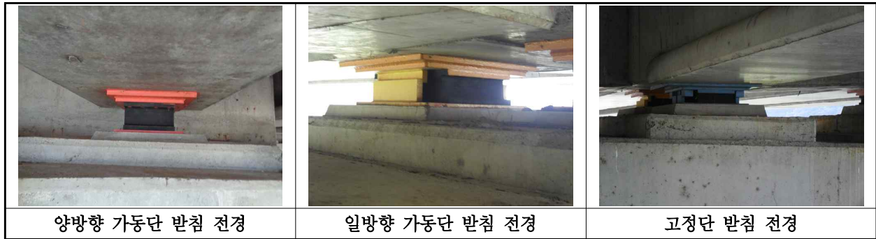
【사진 36.3.37】 교량받침 전경
