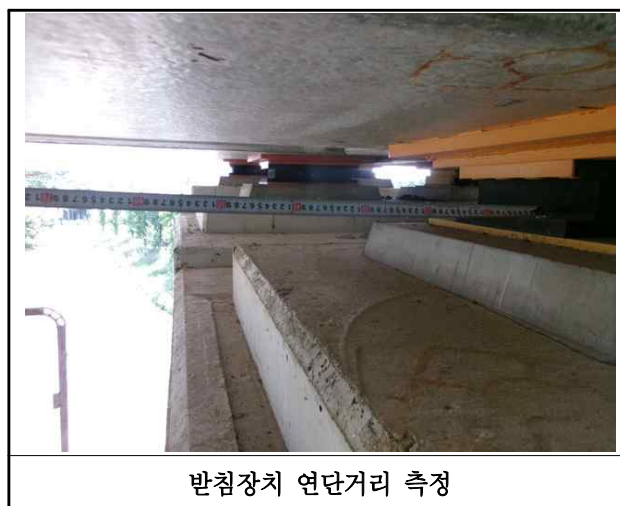
【사진 36.3.39】 교량받침장치 연단거리측정
