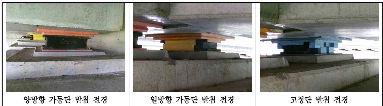
【사진 36.3.12】 교량반침 전경
