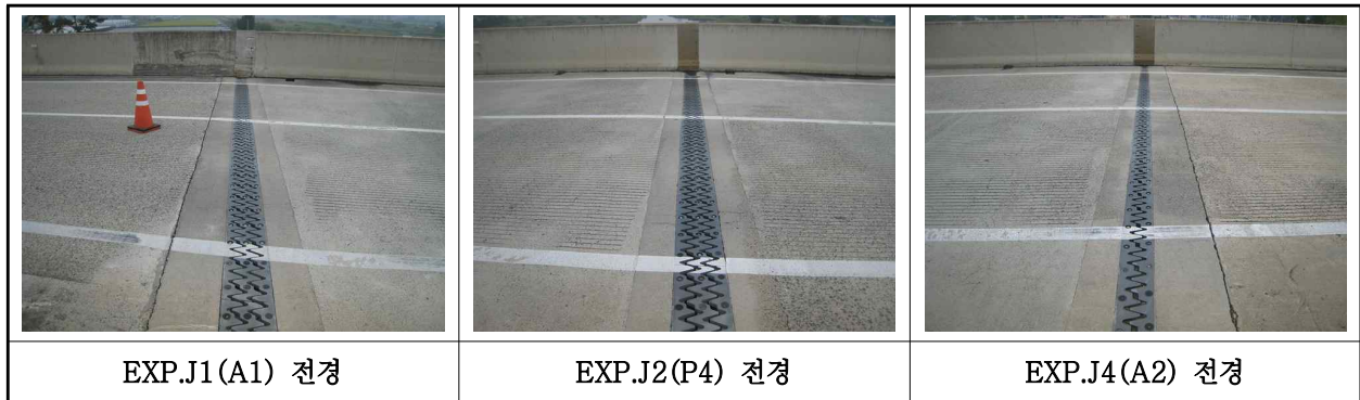
【사진 36.3.41】 신축이음장치 전경
