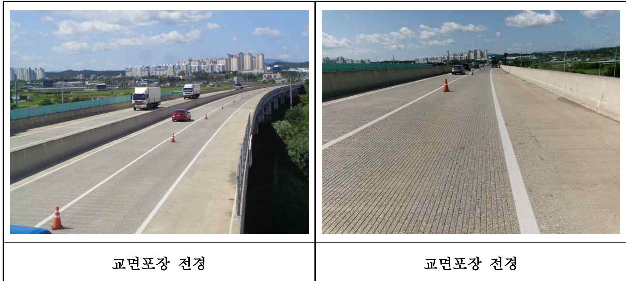
【사진 36.3.19】 교면포장 전경
