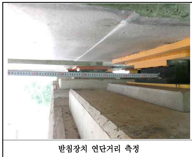
【사진 36.3.14】 교량받침장치 연단거리측정
