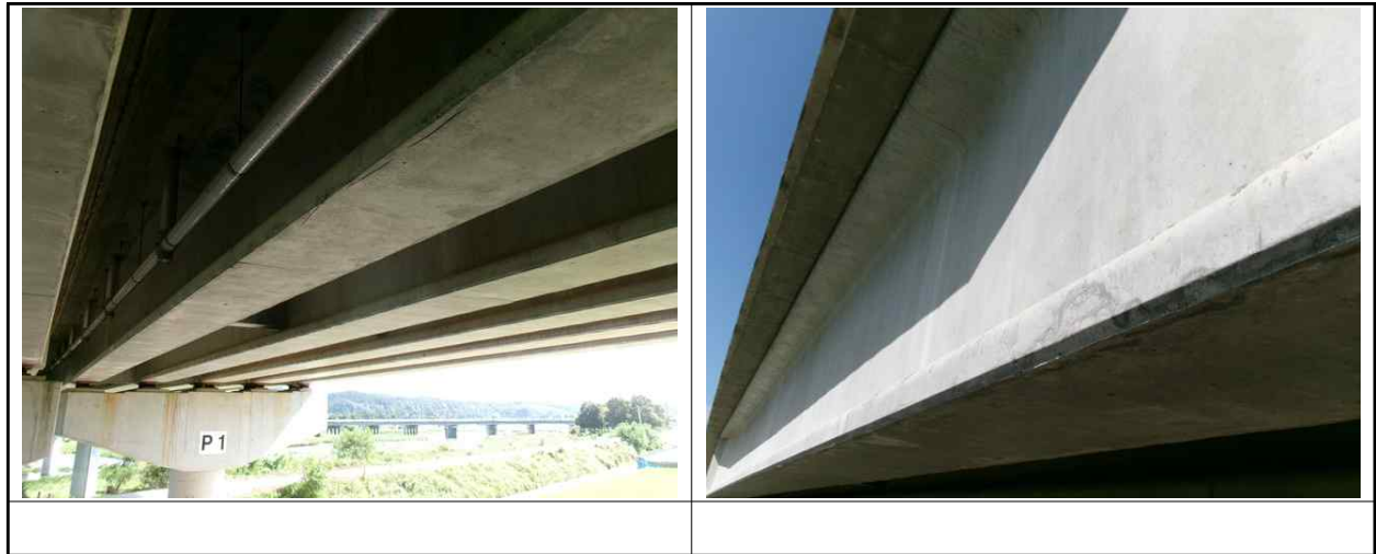
【사진 36.3.29】 거더 전경
