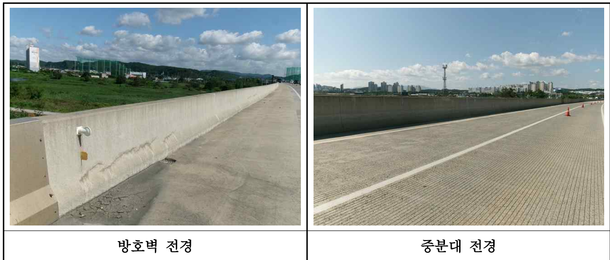
【사진 36.3.23】 방호벽 및 중앙분리대 전경
