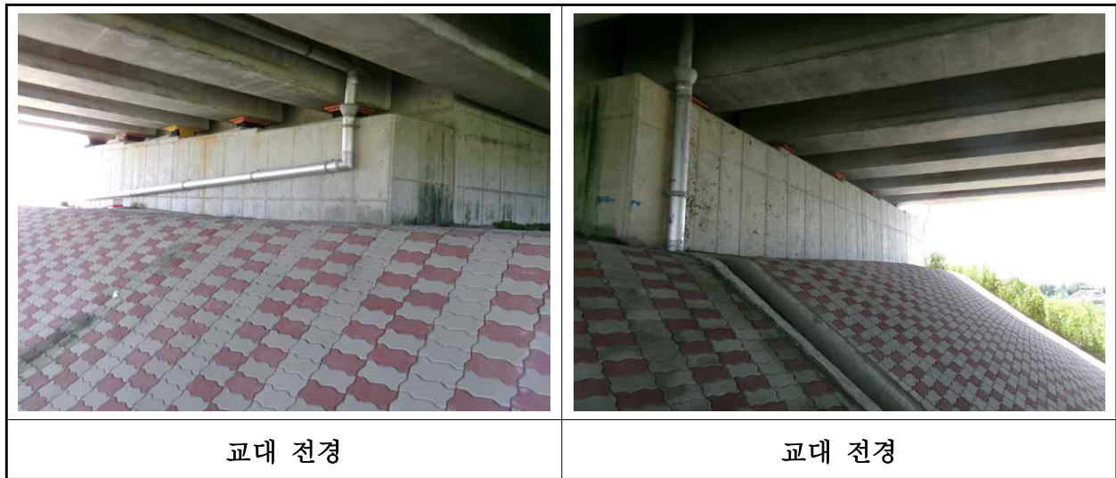
【사진 36.3.33】 교대 전경
