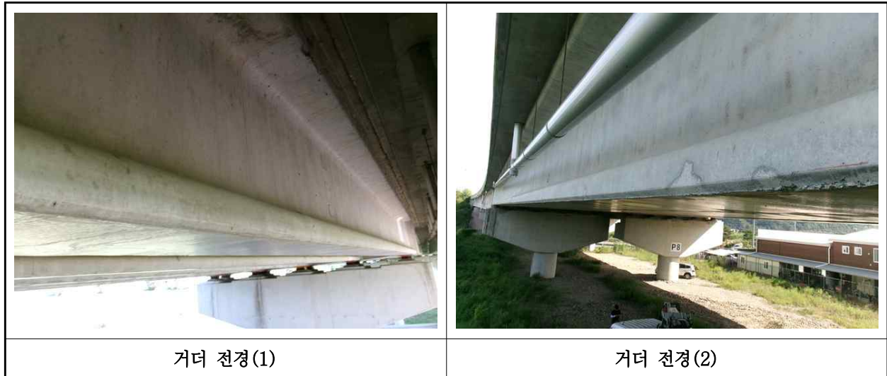
【사진 36.3.4】 거더 전경
