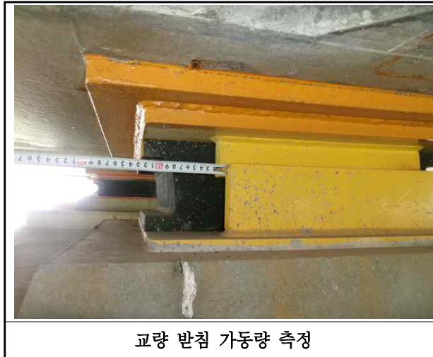
【사진 36.3.15】교량받침 이동량 측정
