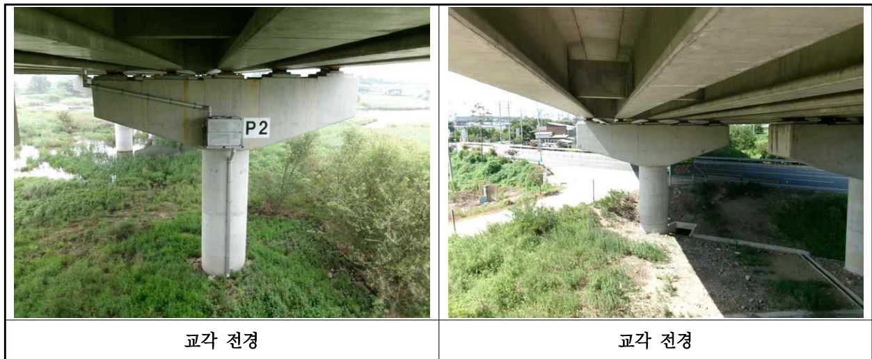
【사진 36.3.35】 교각 전경
