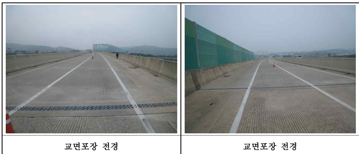
【사진 36.3.44】 교면포장 전경
