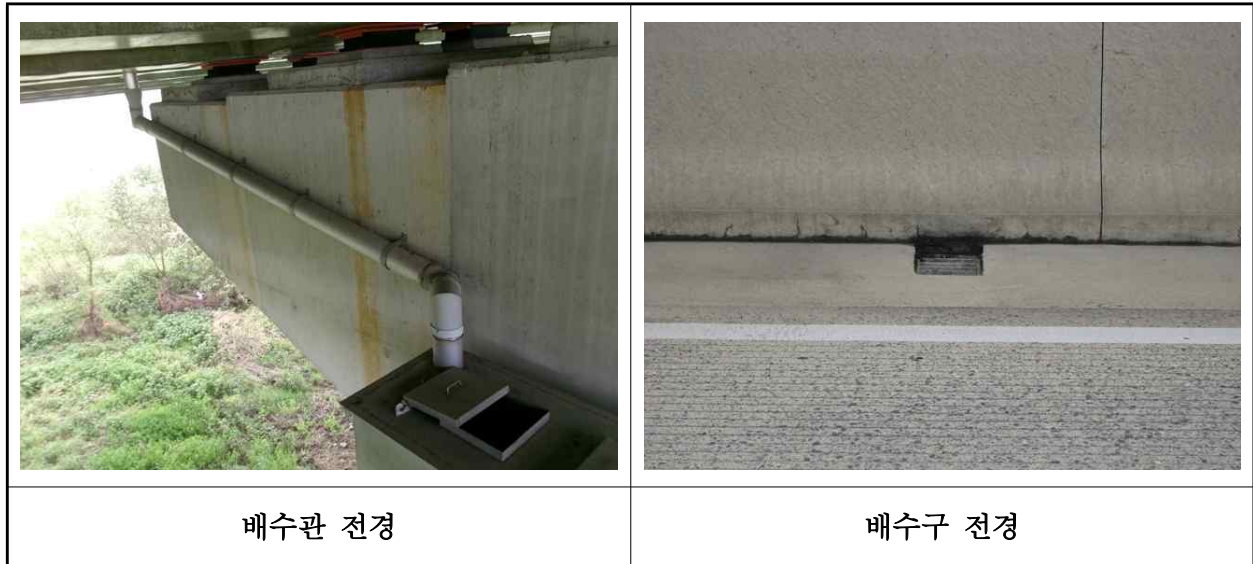
【사진 36.3.46】 배수시설 전경
