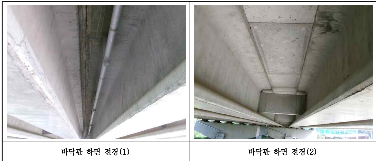
【사진 36.3.27】 바닥판하면 전경
