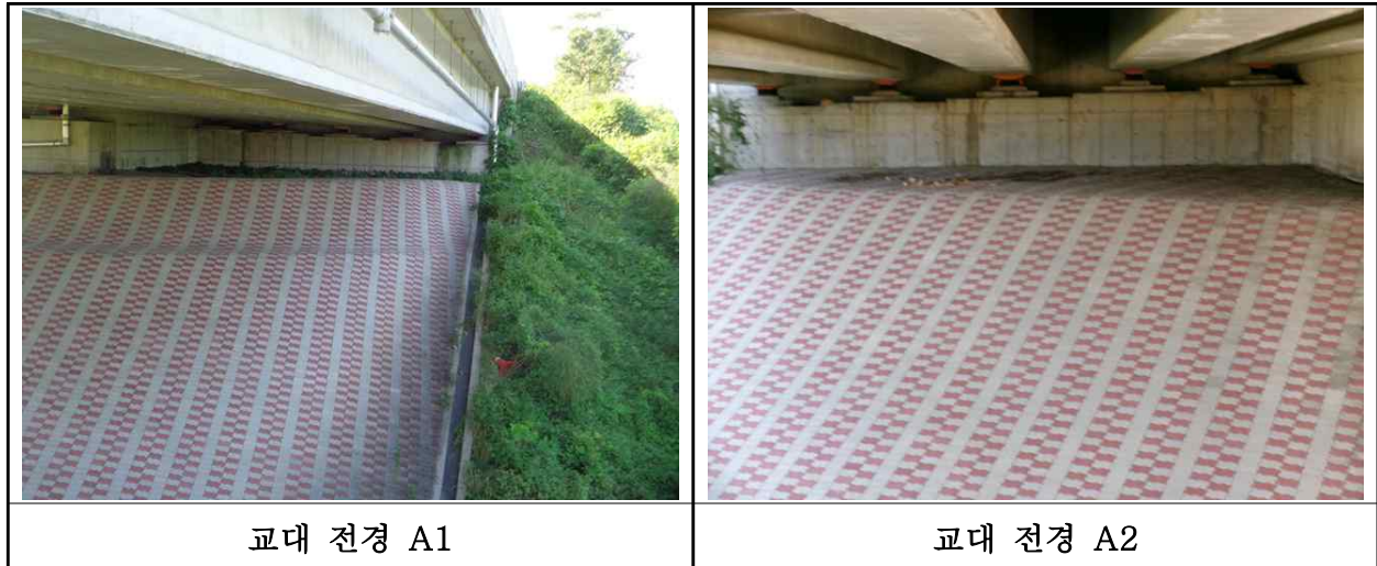
【사진 36.3.8】 교대 전경
