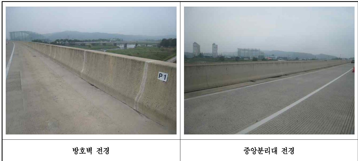
【사진 36.3.48】 방호벽 및 중앙분리대 전경
